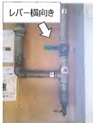
砂型工場稼働時 バルブ遮閉
